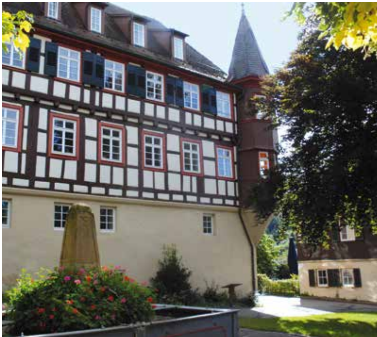
↑ Nachreformatorisch: der Klosterhof mit der alten Oberamtei.
